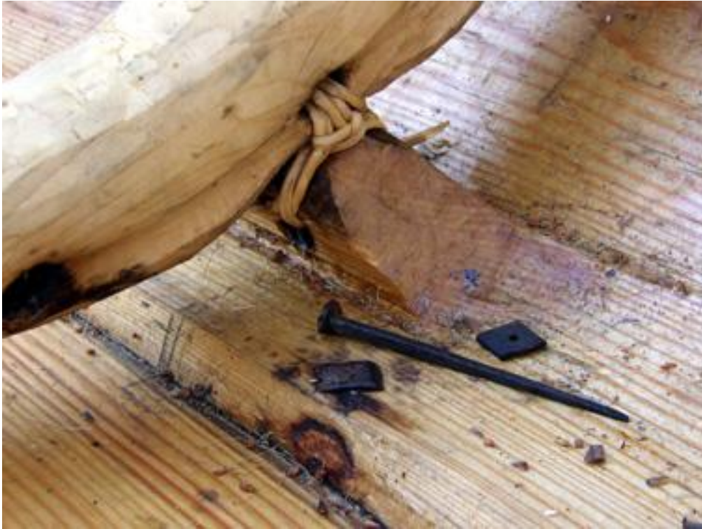
Närbild av surrning, nit och bricka.
